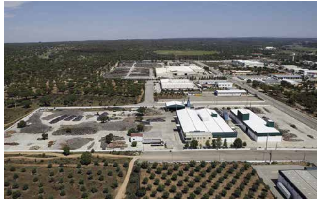
Sedacor III Ponte de Sôr Portugal
