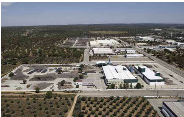
Sedacor III Ponte de Sôr Portugal
