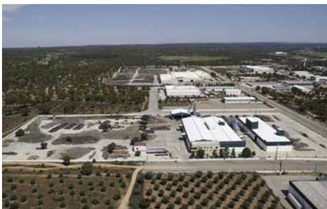
Sedacor III Ponte de Sôr Portugal
